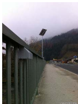
Beleuchtung eines Brücken-Gehweges mit Solar-LED-Leuchten
